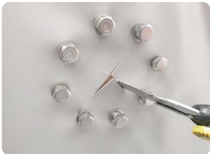
7 - DECOUPER SOIGNEUSEMENT LE LINER EN SUIVANT LA FORME DU TUBE INTERIEUR
