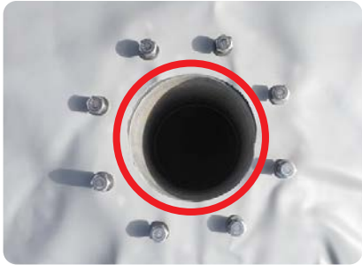
9 - RETIRER LES VIS, APPLIQUER UN BOUDIN DE SILICONE SPECIAL ETANCHEITE AVANT LA POSE DU BLOC BRIDE
