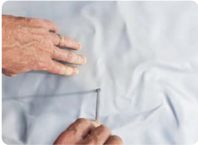
6 - METTRE LE LINER EN PLACE DANS LA CUVE VOIR POSE LINER PAGE 06 PRE-PERCRER LE LINER AVEC UN TOURNEVIS CRUCIFORME SUR 1 POINT DE FIXATION DU PLAT INOX ET PLACER 1 VIS
