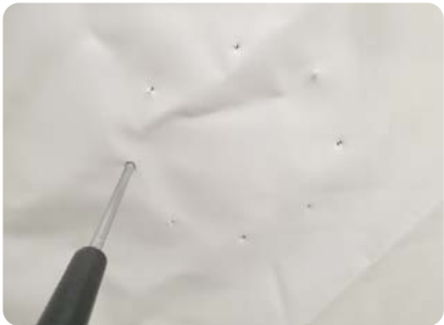
5 - A L'INTERIEUR DE LA CITERNE, PRE-PERCRER LE LINER AVEC UN TOURNEVIS CRUCIFORME SUR LES 8 POINTS DE FIXATION DU BLOC BRIDE INOX
