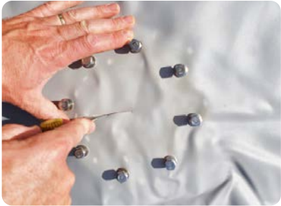
8 - POSITIONNER TOUTES LES VIS, DECOUPER SOIGNEUSEMENT LE LINER EN SUIVANT LA FORME DU TUBE INTERIEUR
