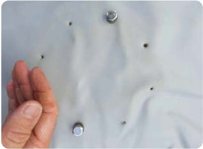
7 - PRE-PERCRER UN DEUXIEME TROU A L'OPPOSER DU PREMIER, PLACER UNE VIS. PRE-PERCRER LES AUTRES TROUS
