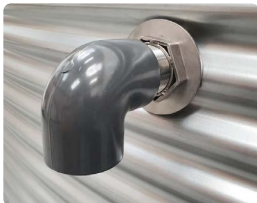
VUE EXTERIEURE TROP-PLEIN CITERNE
