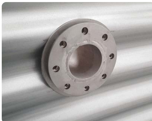
VUE INTERIEURE TROP-PLEIN CITERNE AVANT POSE DU LINER
