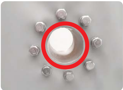
8 - RETIRER LES VIS, APPLIQUER UN BOUDIN DE SILICONE SPECIAL ETANCHEITE AVANT LA POSE DU BLOC BRIDE
