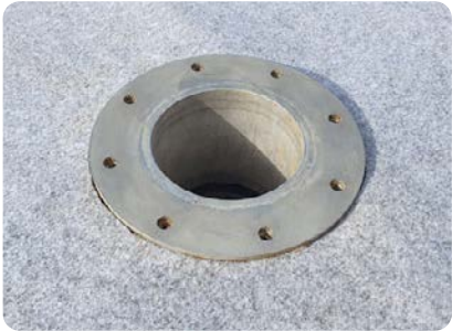
5 - RESULTAT A OBTENIR AVANT POSE DU LINER
