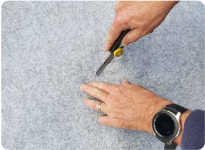
4 - POSITIONNER LES BANDES DE TAPIS DE SOL SUR TOUTE LA PLATE-FORME DECOUPER LE TAPIS DE SOL POUR, LIBERER LE PLAT INOX
