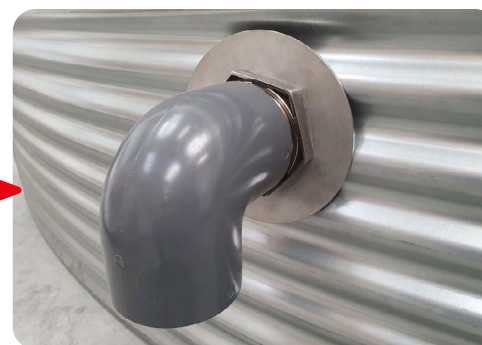
Visser le coude PVC et orienter la sortie vers le bas. Bloquer l'écrou.
