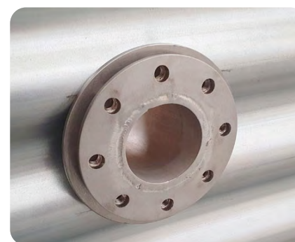
Vue intérieure trop-plein citerne avant pose du liner.
