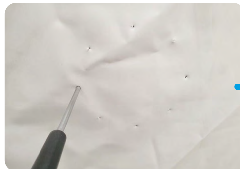
A l'intérieur de la citerne, pré-percer le liner avec un tournevis cruciforme sur les 8 points de fixation du bloc bride inox.
