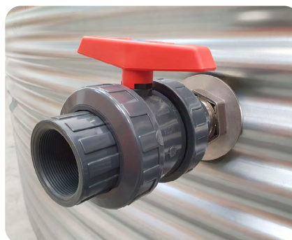
Visser le coude PVC et orienter la sortie vers le bas, visser la vanne de remplissage. Bloquer l'écrou. La traversée de cloison ne doit plus tourner sur elle-même.
