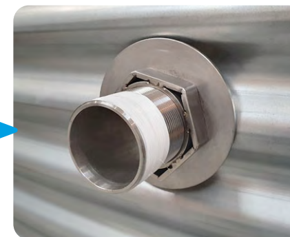
Poser du téflon sur le filetage (sens horaire) avant de visser le coude PVC ou la vanne.
