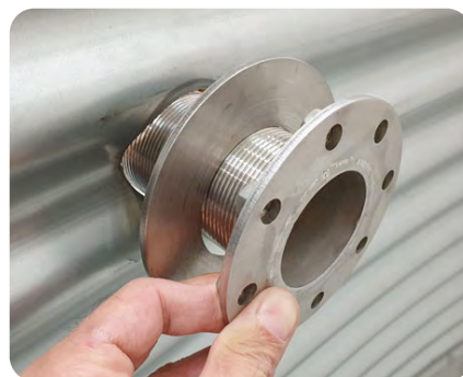
Enfiler la traversée de cloison avec une rondelle de l'intérieur vers l'extérieur de la citerne.
