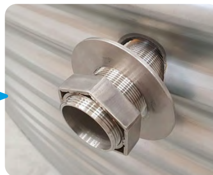
Enfiler une rondelle et l'écrou à l'extérieur de la citerne. Ne pas bloquer l'écrou avant la pose du coude PVC ou de la vanne.
